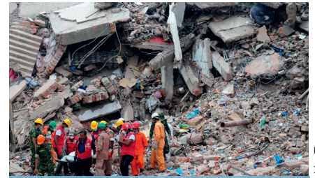
Les secours après l'effondrement.
